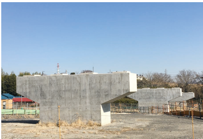
秦野厚木道路 鈴川橋
